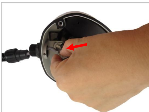
Using Flex Conduit
